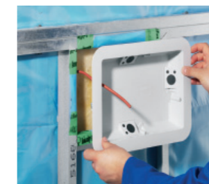
Installasjon med utenpåliggende lekt.
