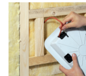
Installasjon med innenforliggende lekt.
