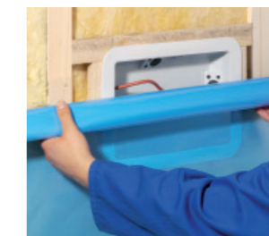
Installasjon med innenforliggende lekt.
