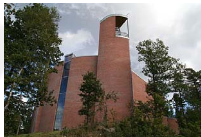
Søm Kirke, Kristiansand KNX-prosjekt, offentlig bygg/kirke
